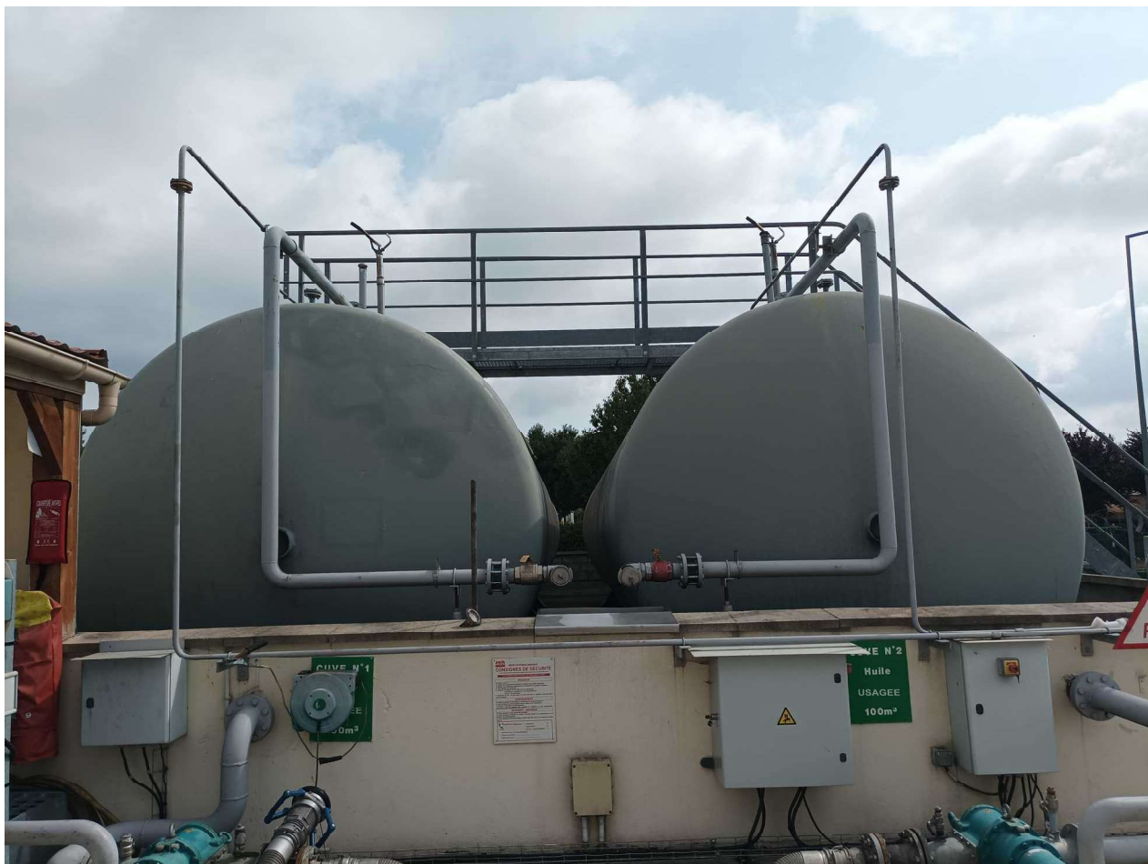
Illustration des deux cuves de regroupement d'huiles usagées
