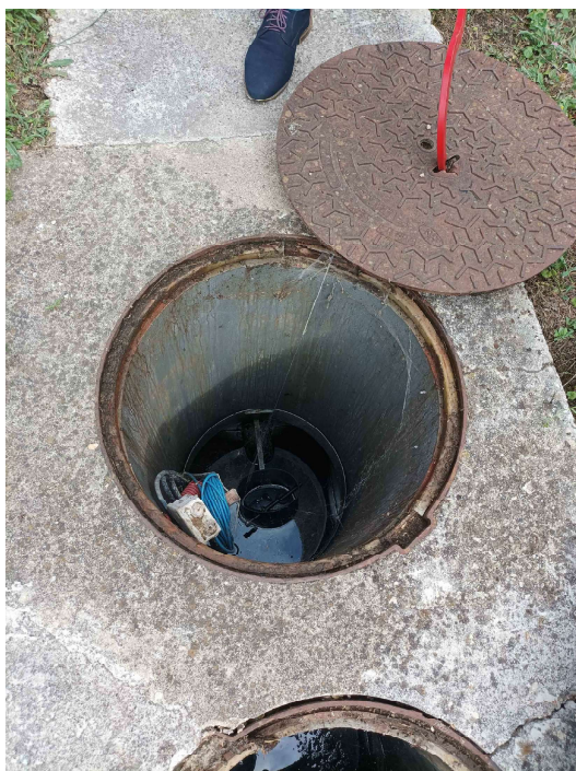
Illustration de l'accès au séparateur d'hydrocarbure en date du 21 juillet 2022
