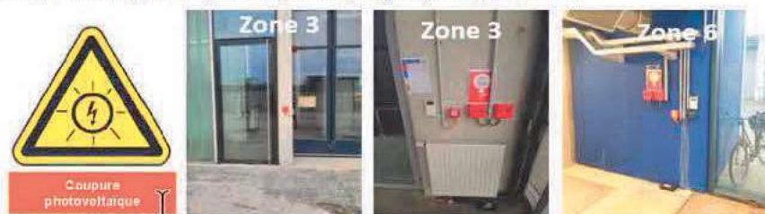
Figure 41 : signalisation de la coupure d'urgence et localisation des moyens de coupure d'urgence
