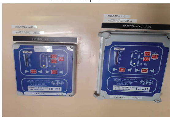
Usine n°1 : Détecteurs fuite de chlore – derrière local exploitation
