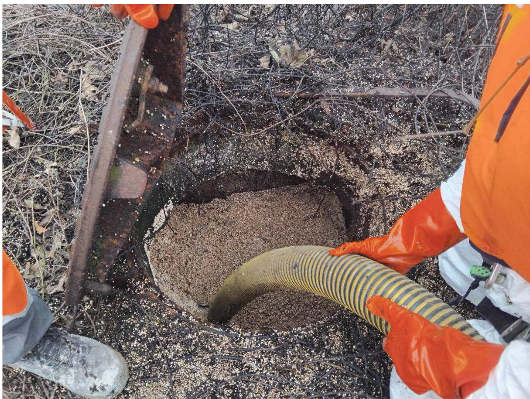
Pompage au niveau d'un puits au rejet en Seine
