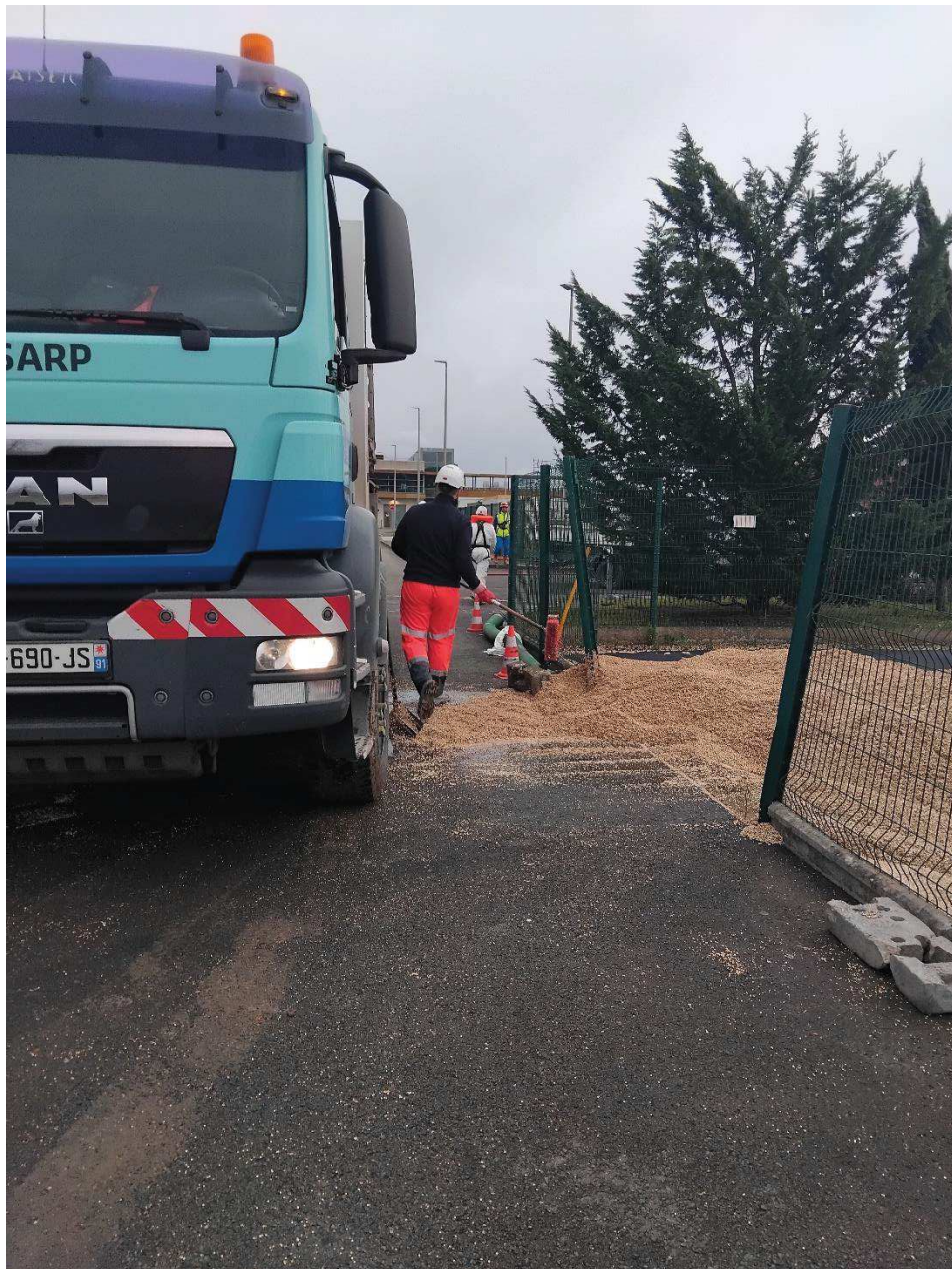
Déchargement de billes dans le bassin de confinement
