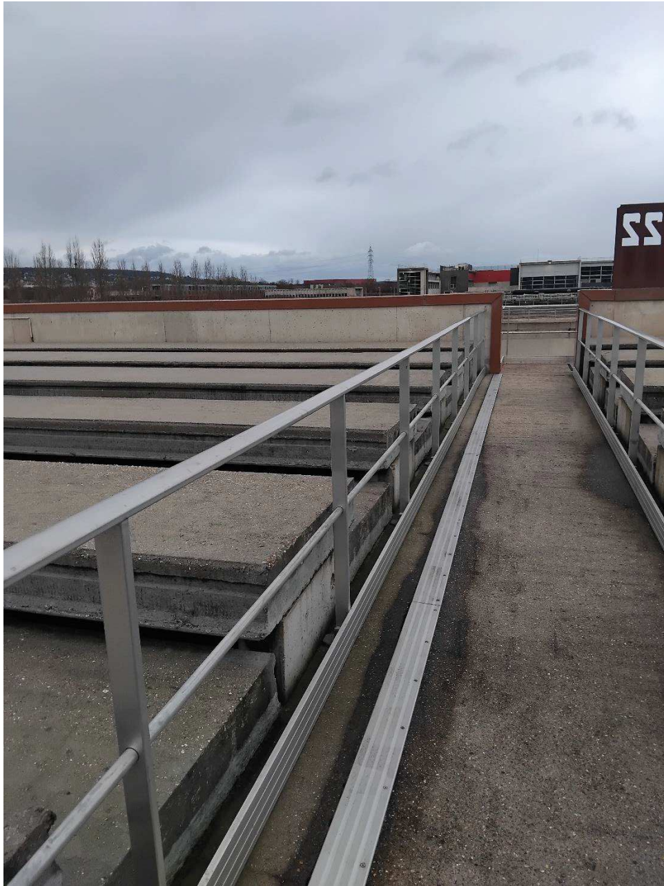
Dessus des bassins des filtres de la pré dénitrification
