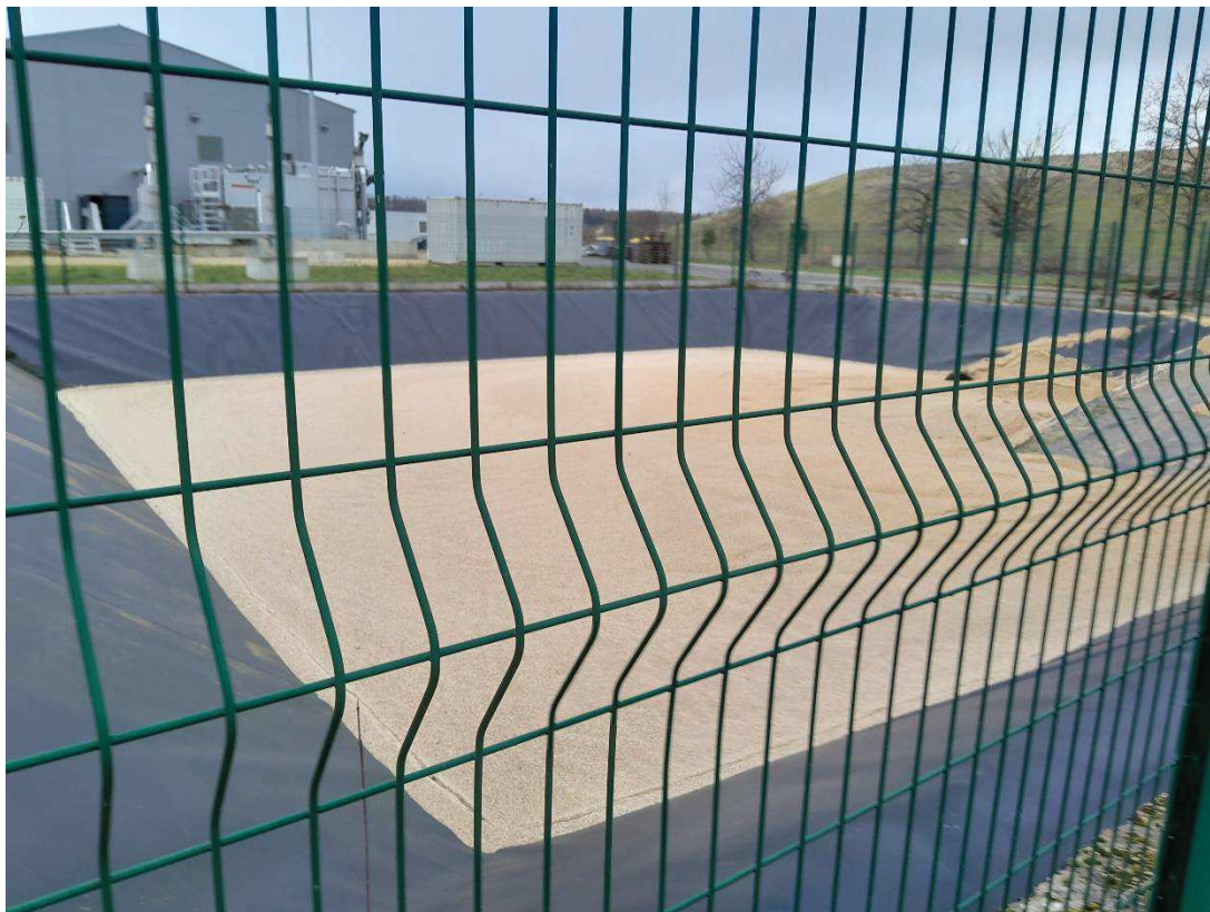
Bassin de confinement des eaux d'extinction incendie
