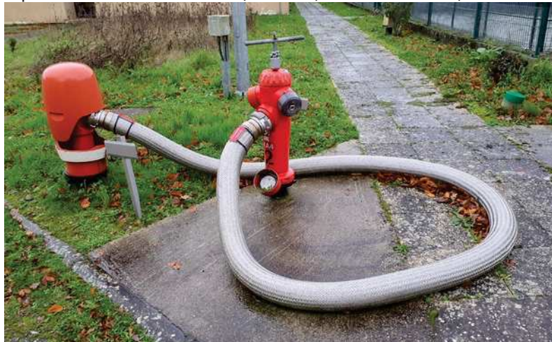
Raccordement du nouveau réseau incendie via un poteau de l'ancien réseau
