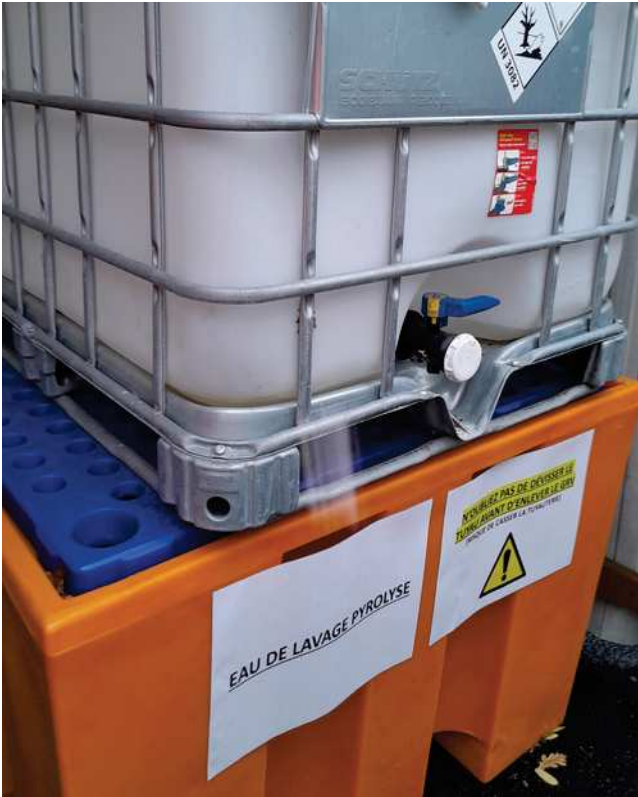
Photo 1 : GRV qui contient les eaux de lavage pyrolyse sur rétention
