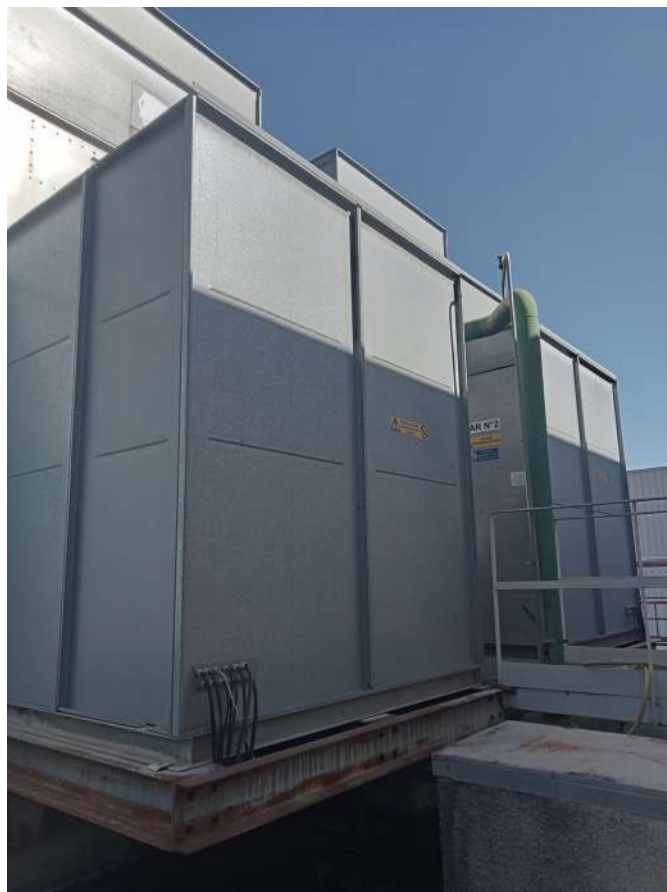
TAR positionnées en toiture, accessibles via une échelle à crinoline
