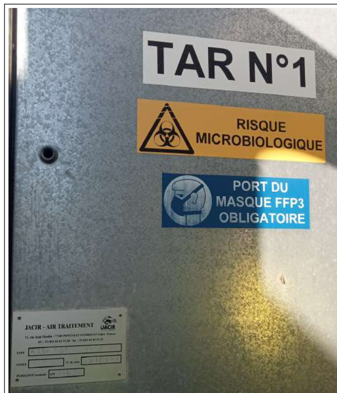
TAR n° 1 avec plaque constructeur année 2009 puissance nominale : 1 163 kW
