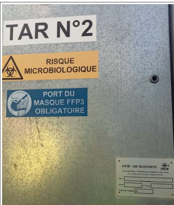
TAR n° 2 avec plaque constructeur année 2009 puissance nominale : 1 163 kW
