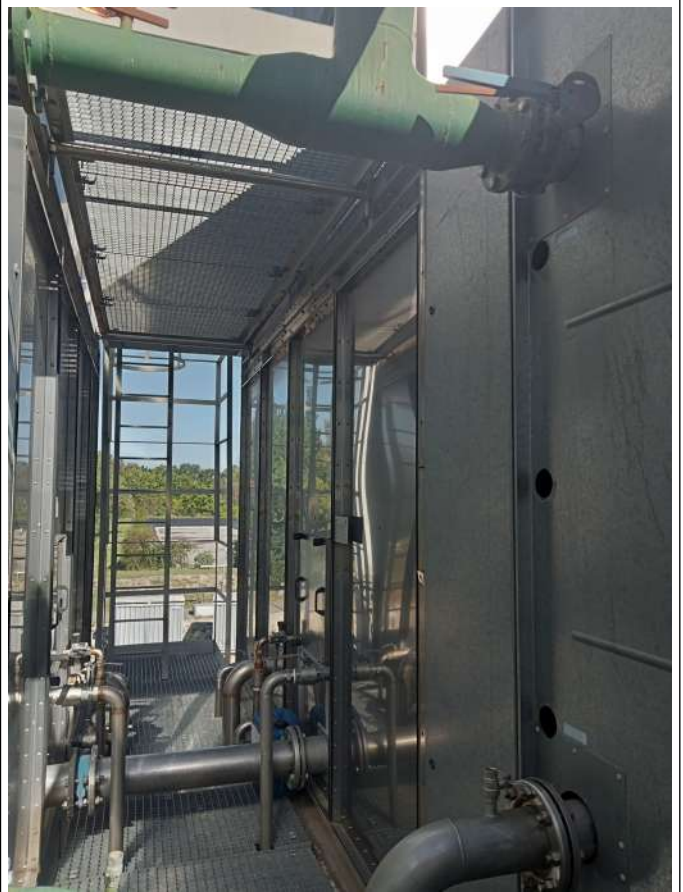
Canalisations d'arrivée du fluide chaud et d'évacuation du fluide refroidi
