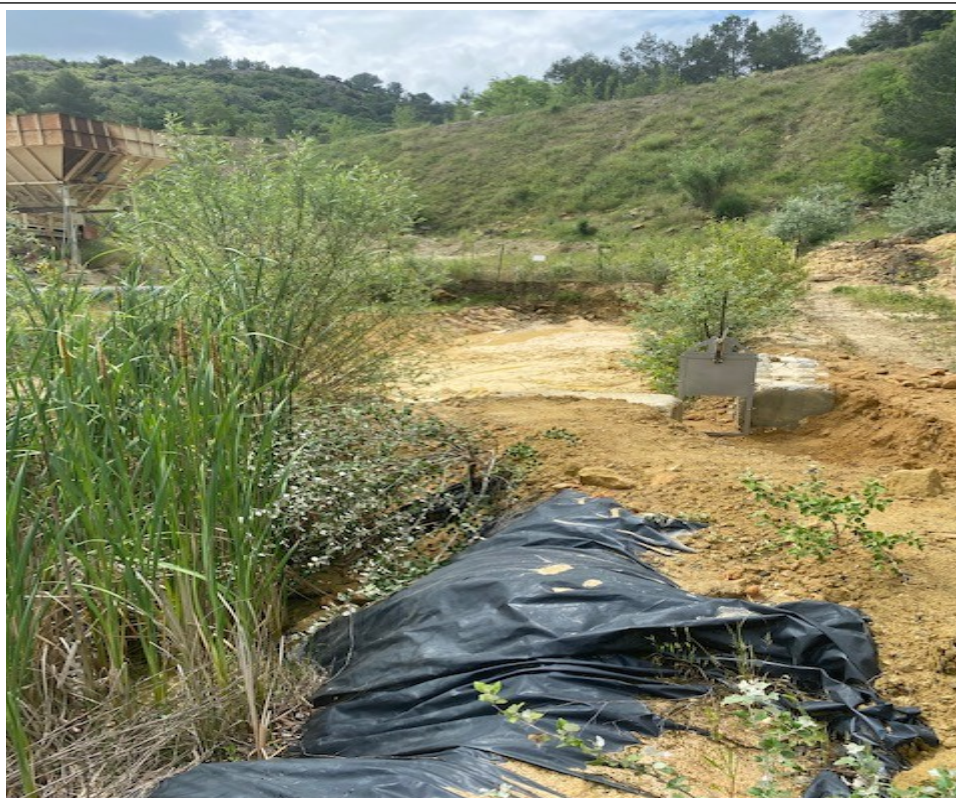
Photos n°4 – 3 e bassin en travaux avec vannes martellière
