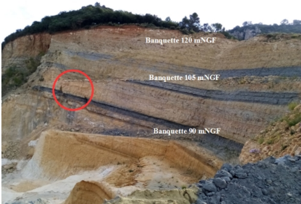
Fronts de la zone sud (zone fissurée cerclée en rouge)
