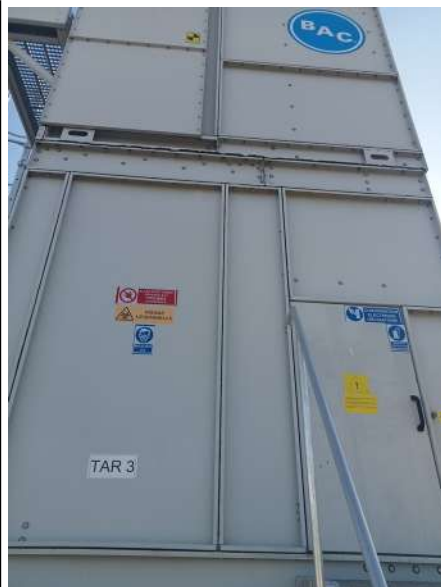
TAR n° 3 avec plaque constructeur puissance nominale : 1 150 kW
