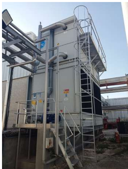
TAR n° 1 avec plaque constructeur puissance nominale : 2 276 kW
