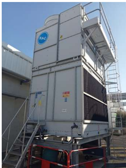
TAR n° 2 avec plaque constructeur puissance nominale : 1 150 kW
