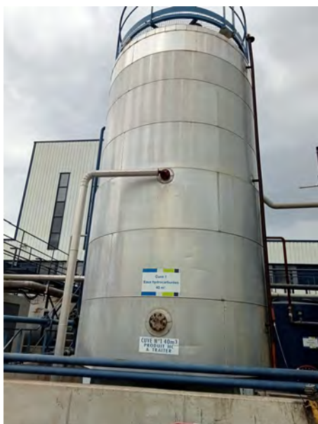
Cuve "eaux hydrocarbonnées" chauffée sur rétention S4 avec contrôle de niveau à droite
