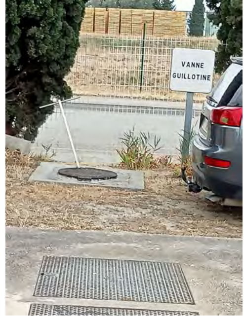
Vanne de fermeture réseau pluvial n°1
