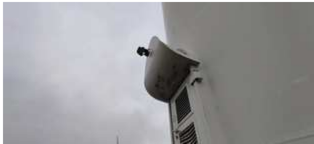
Éclairage avec détecteur de présence
