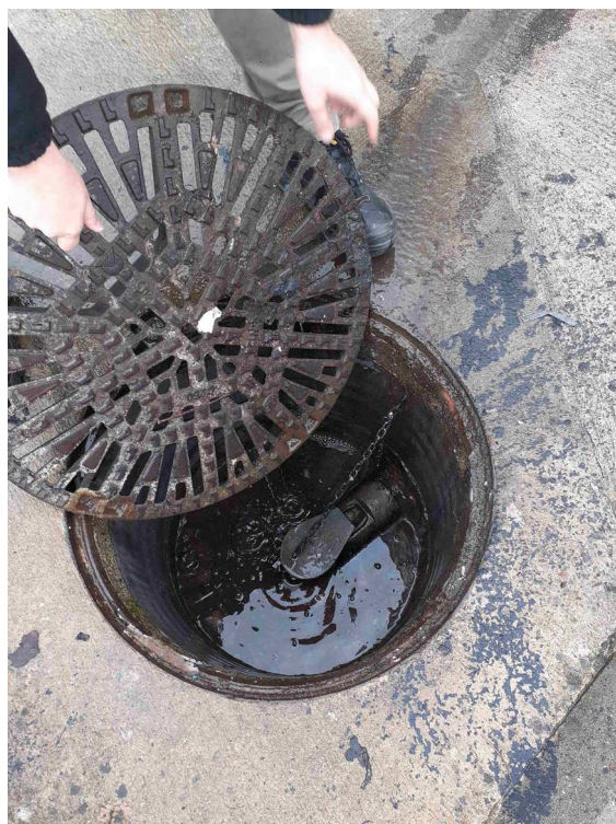
clapet de fermeture en amont du bassin de confinement
