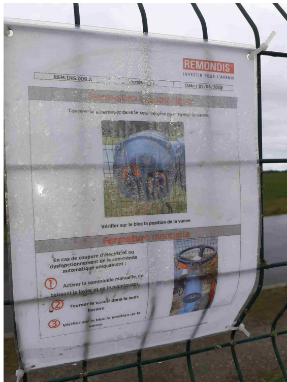
procédure d'utilisation vanne de sectionnement
