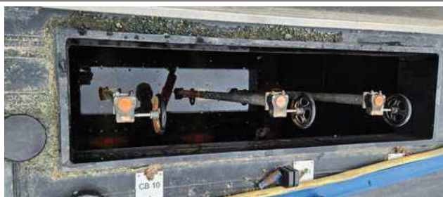
Système de vannes CB10 → CB 12 pour la gestion des lixiviats des casiers
