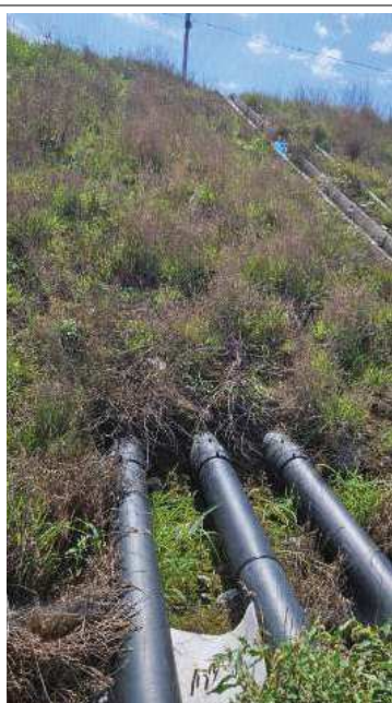
Exemple de traversée de digues des 3 collecteurs de lixiviats D7.1 à D7.3 (réseau Nord)
