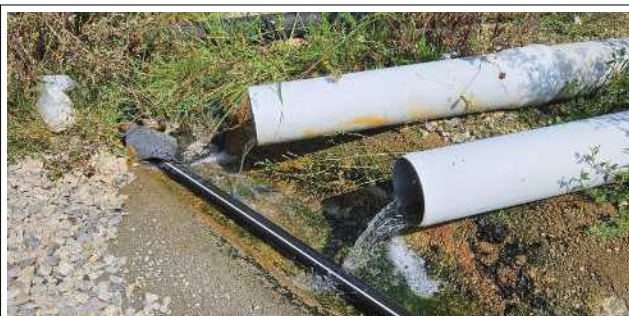
Rejet temporaire en eau pluviale des subdivisions de D7
