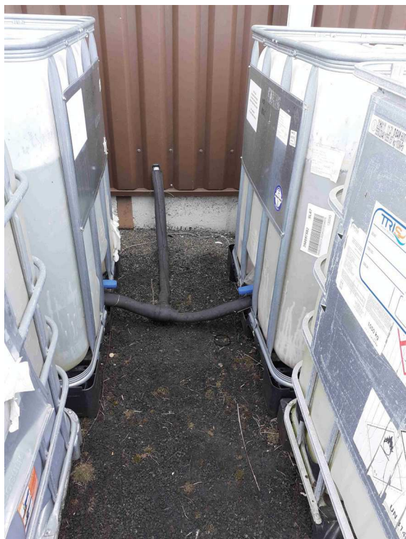
broyeur :réserve d'eau extinction automatique
