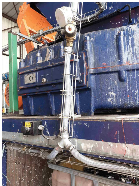
broyeur : arrivée d'eau pour les buses d'extinction
