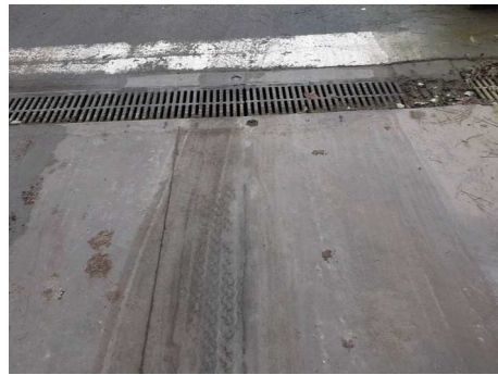
Grille de récupération des eaux du bâtiment mâchefers (eaux en recirculation)
