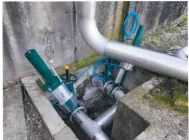
"vannes de soutirage des 2 bassins de collecte"
