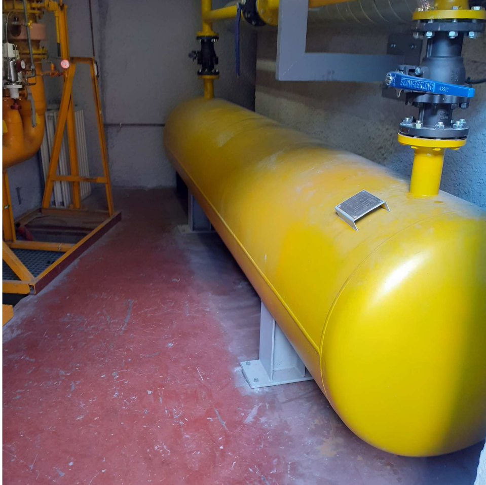
Capacité de diamètre nominal 800 et pression de service 15 bar
