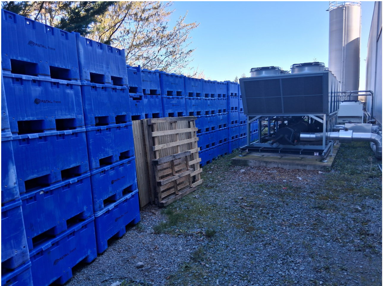
Mise en place d'un dispositif d'obstacle à la propagation des nuisances sonores des équipements du site (partie Est)
