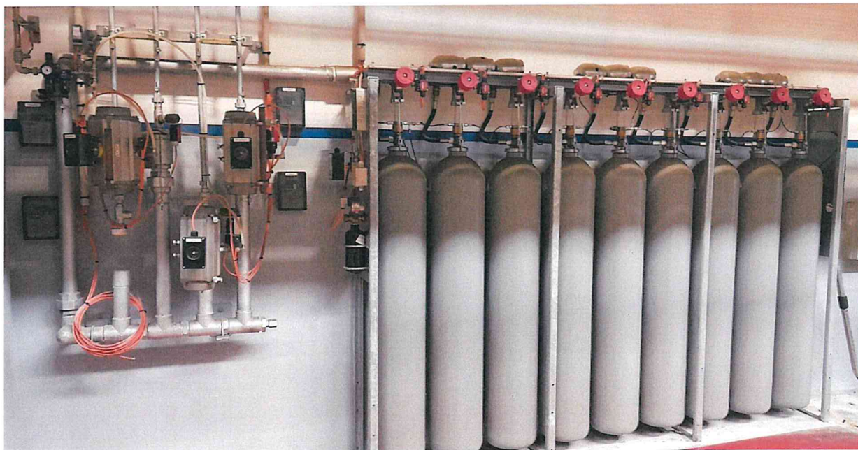
Extinction automatique installation "trempe huile".
