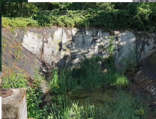
Bassin de rétention des eaux d'extinction d'un incendie
