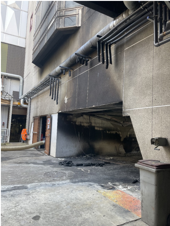
Vu du local incendié depuis la cour intérieur + tuyauteries fondues le long de la façade 26/05/23
