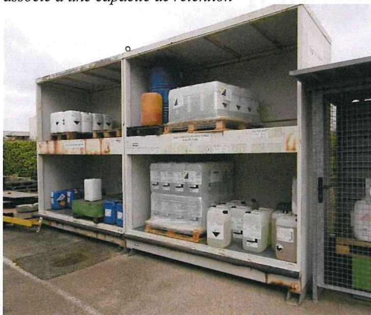
Vue n° 5 – Stockage de produits dangereux correctement associé à une capacité de rétention
