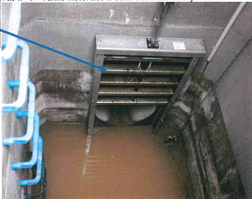
Vue n° 4 – Vanne motorisée d'obturation des eaux pluviales
