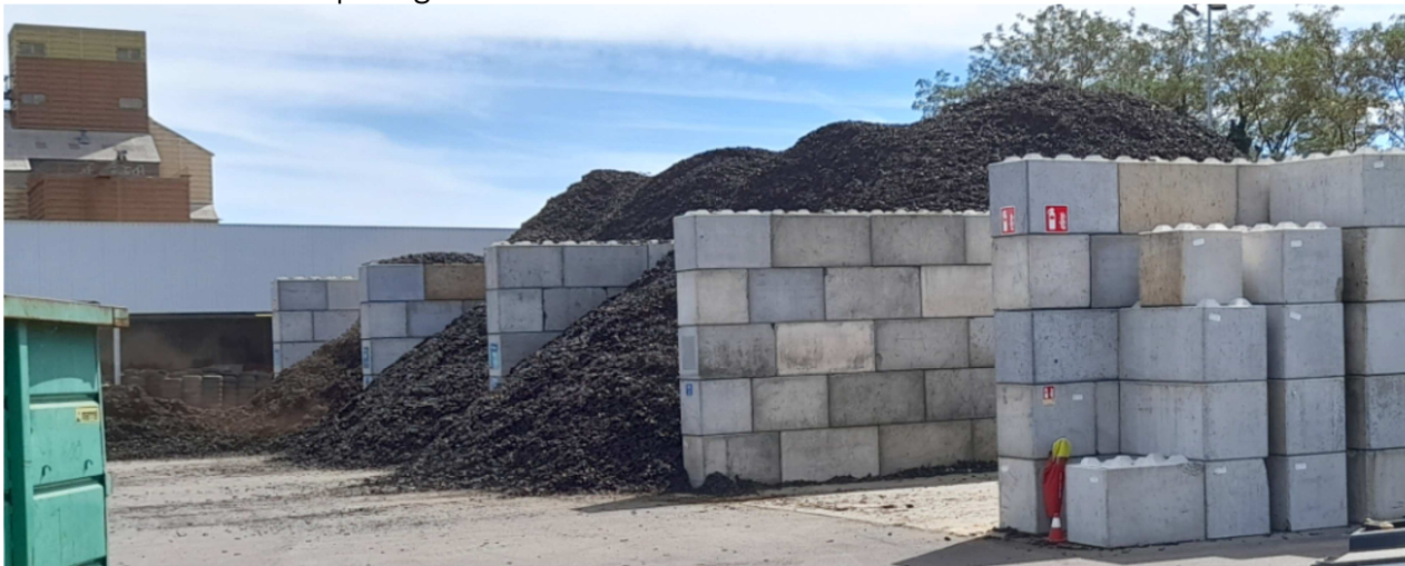
Photo prise le 24/08/2022. Hauteur du mur en blocs : 4m.
