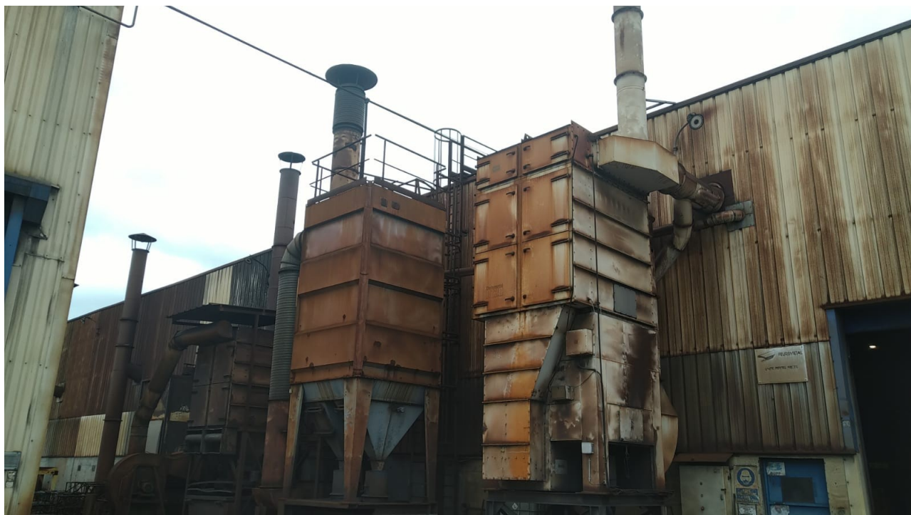
Installations de 3 rejets atmosphériques des grenaillageuses (Sud)
