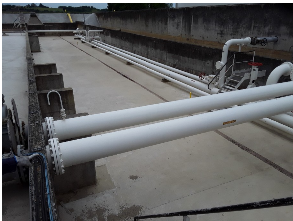
Sous-cuvette B – passage de tuyauteries
