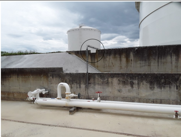
Espace merlon entre 2 sous-cuvettes
