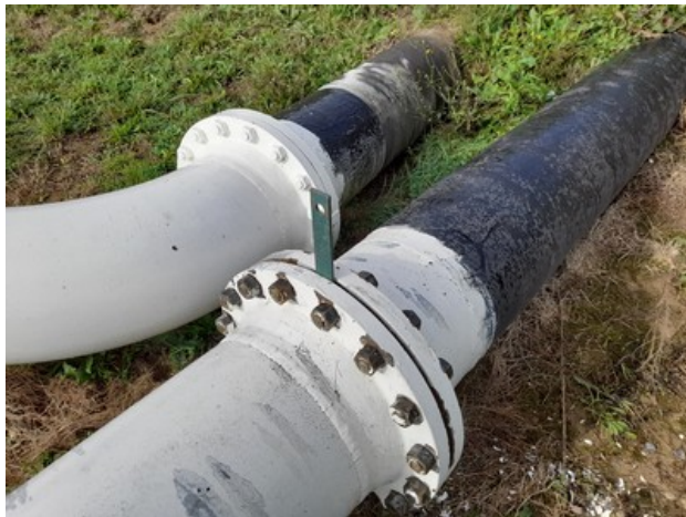
Platine qui obstrue la circulation de fluides dans la tuyauterie
