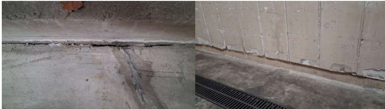
Fissure à la jonction sol / mur (cellule D1.6)
