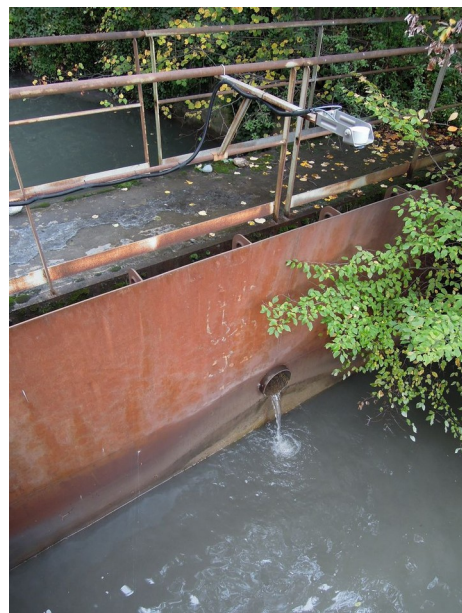
Surverse au milieu naturel du bassin de refroidissement
