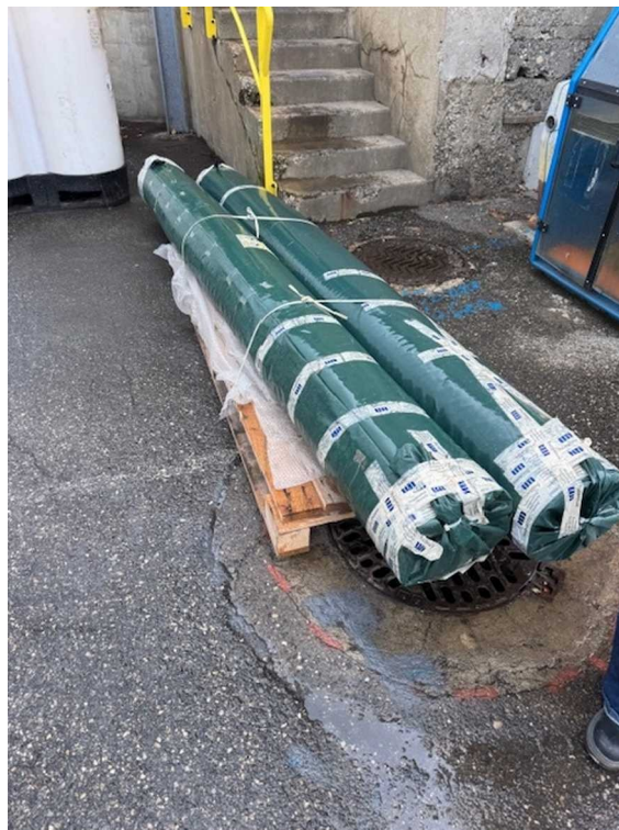
Regard d'eaux pluviales bloqué par un colis empêchant la mise en place de plaque obturante en cas d'épandage accidentel
