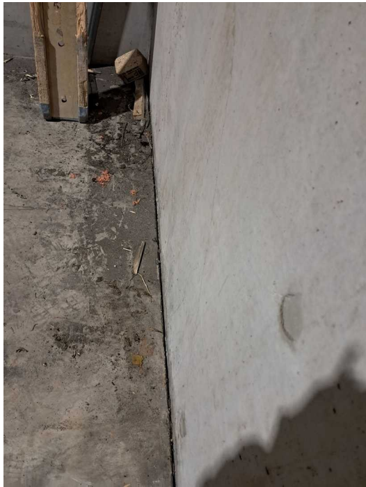
Zone de dilatation périphérique du bâtiment « produits finis » avec vide d'environ 2 mm de large
