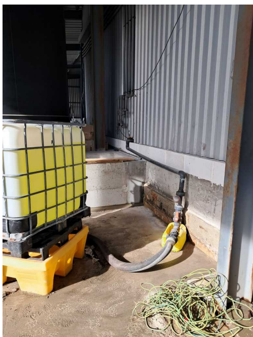
Zone de tuyauterie fixe pour le dépotage sous l'auvent
