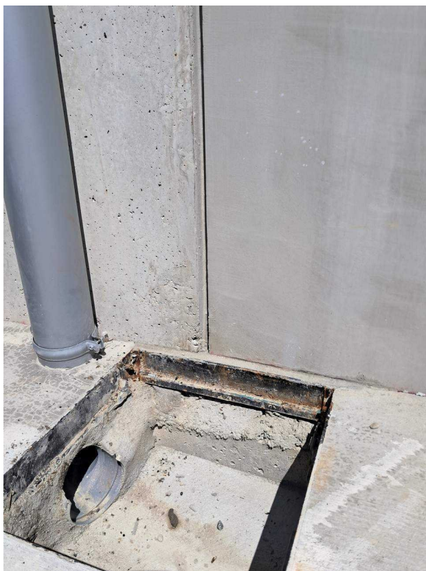
Regard dans la zone de quai de la zone de production (étanchéité OK)
