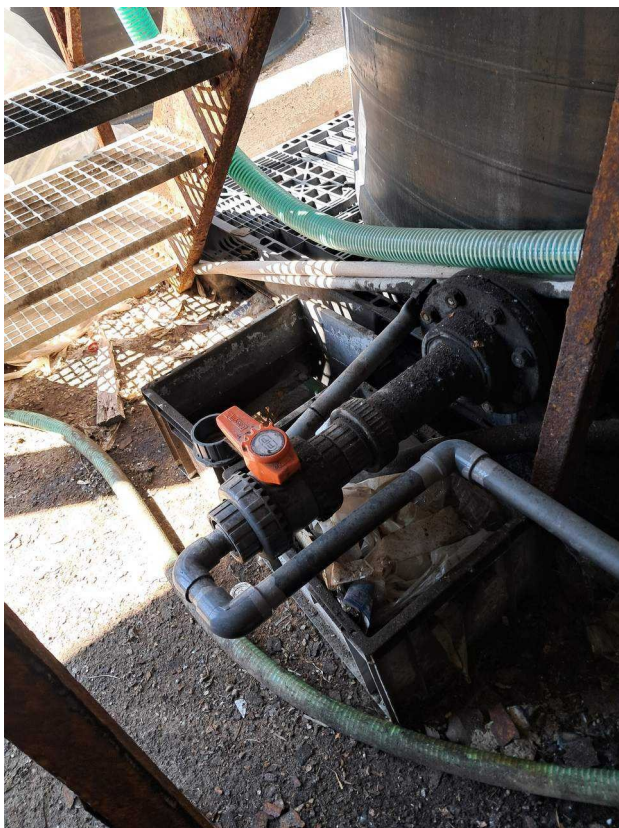
Vanne de pied de bac de prétraitement fermée
