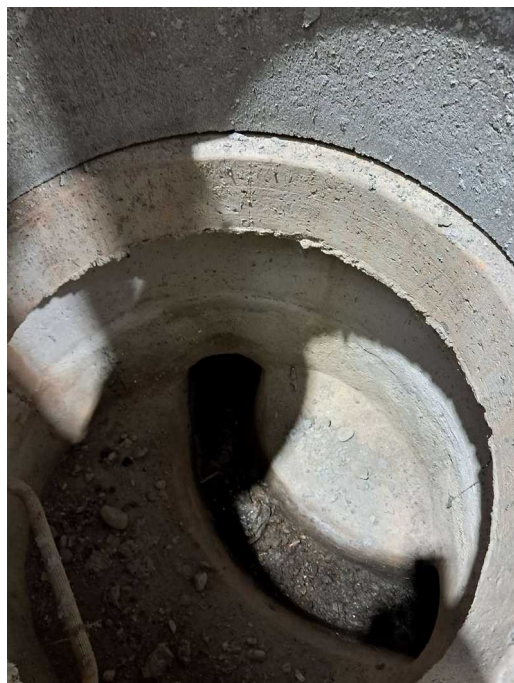
Intérieur d'un regard non étanche situé dans le bâtiment « produits finis » au ras de la dalle
