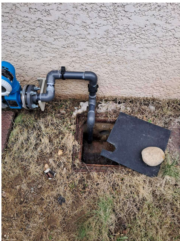
Photo du point de rejet d'eaux industrielles (eaux osmoseur + eaux traitées)
