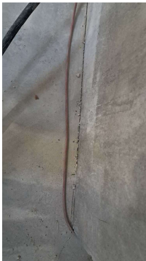
Photos des bords de la dalle béton du bâtiment Nord sans joint du 10/12/2024
