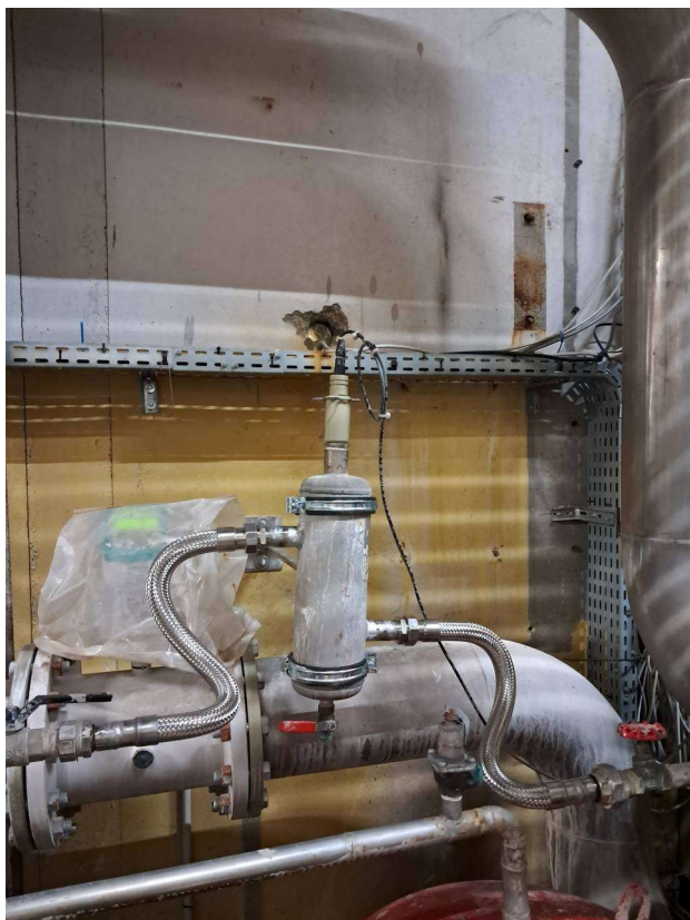
Sondes pH dans la salle des machines ammoniac
