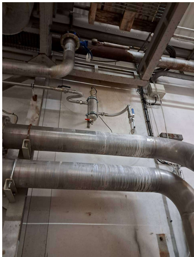
Sondes pH dans la salle des machines ammoniac
