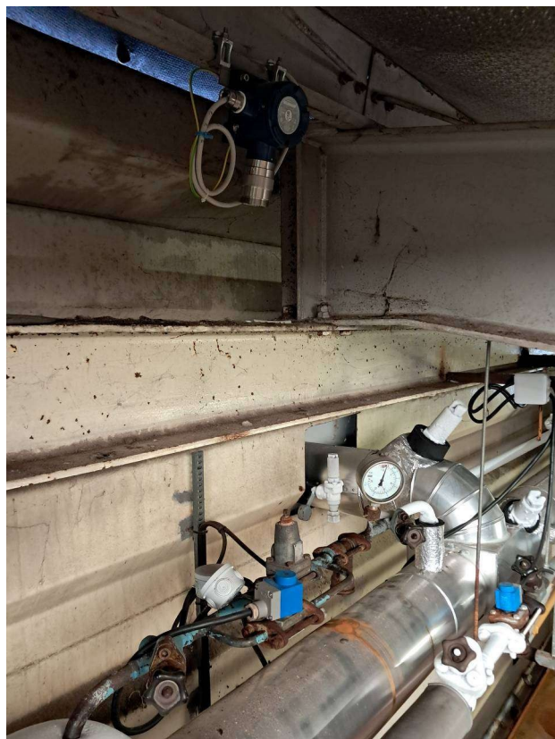
Détecteur n°7 « station de vannes chambre 1 »
