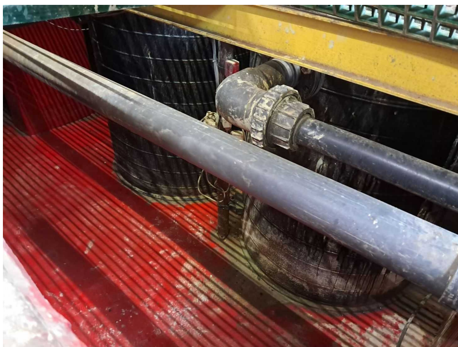
Rétention sous station de neutralisation
