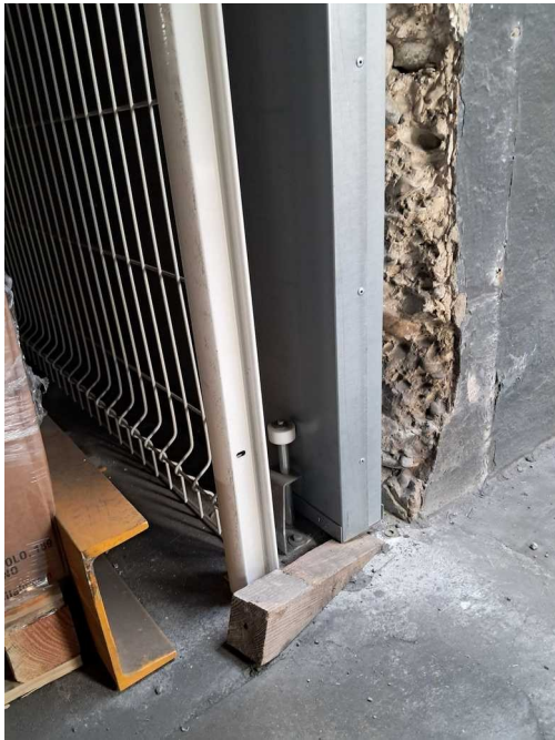
Porte coupe-feu maintenue bloquée dans la paroi 6
