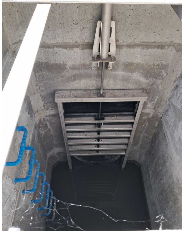
Vanne d'isolement Est en train de se fermer
