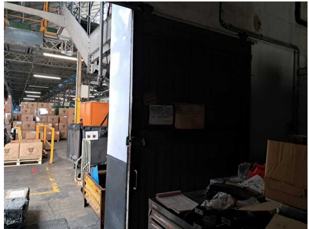
Porte coupe-feu absente entre le magasin pièces détachées et l'atelier montage
