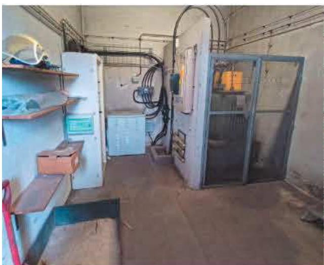
Transformateur, sur rétention et accès limité
