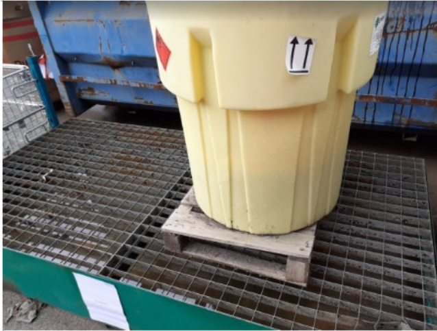
Rétention extérieur emplie d'eau et contenant non clairement identifié.
