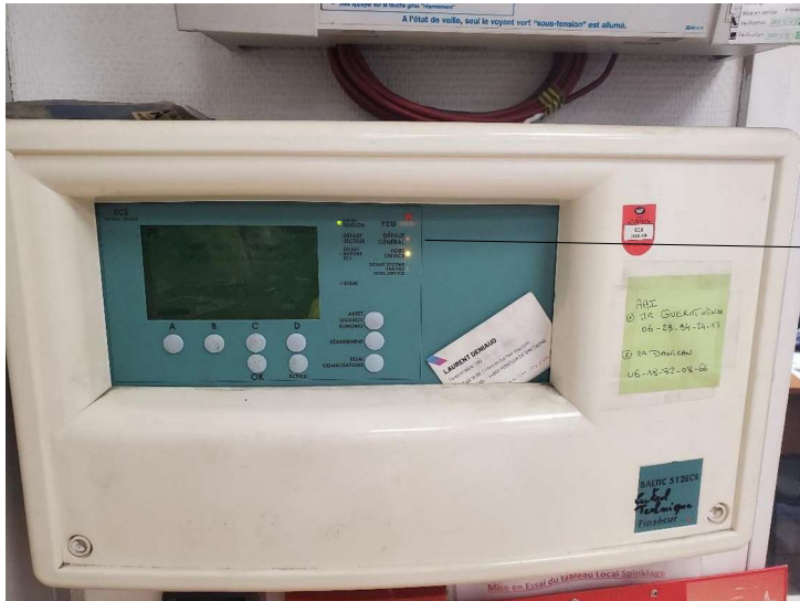
Photo 1 : Centrale de détection affichant « hors service »
