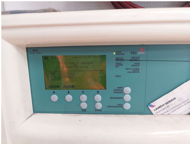
Photo 2 : Centrale de détection, après le passage de la société AAI, affichant « sous-tension »
