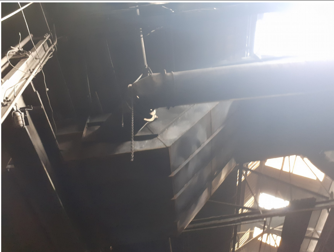
Coude de conduite ayant fait l'objet des travaux de soudure et du départ de feu
