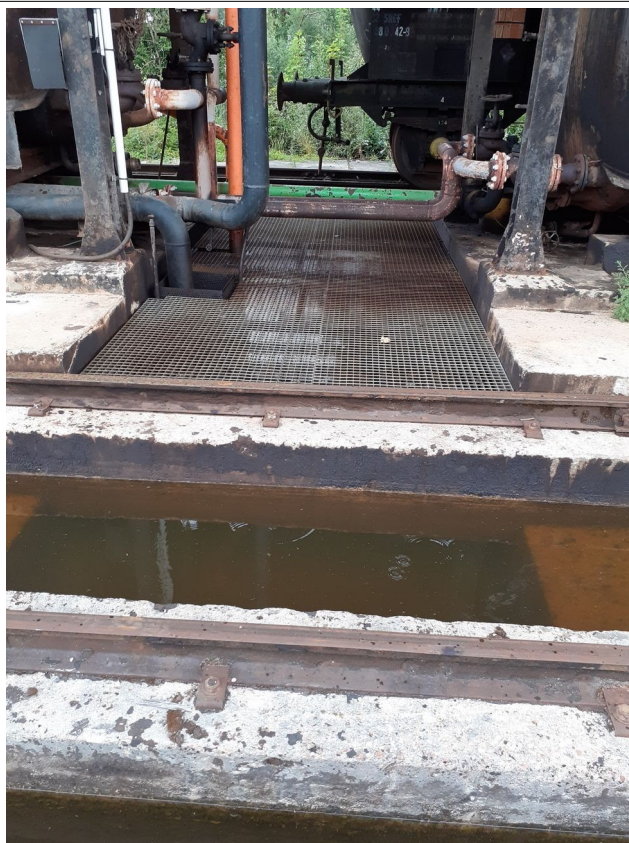
Fûts brûlés sur rétentions presque pleines et non protégées des eaux pluviales
