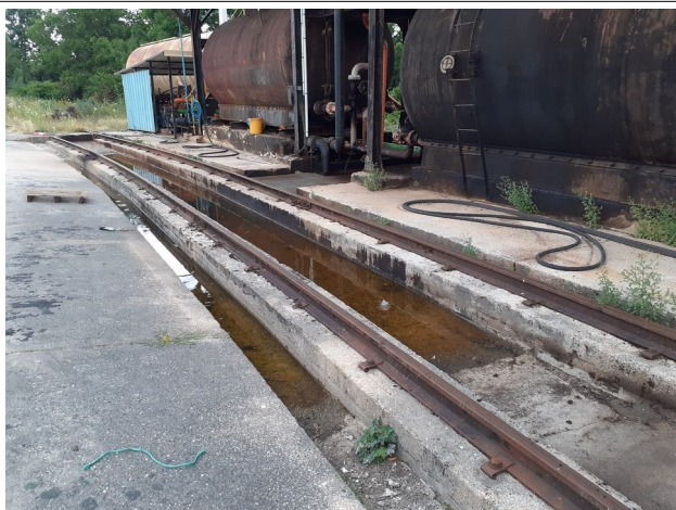
Zone en partie non protégée des eaux pluviales
