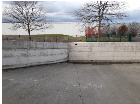
Bassin de confinement + surverse en point haut
