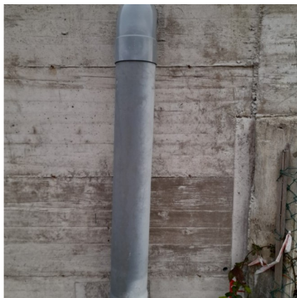
Descente de la surverse au regard extérieur
