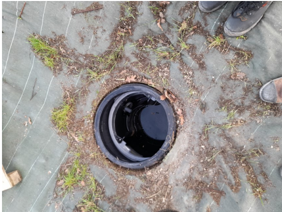
Trous d'homme du séparateur d'hydrocarbures
