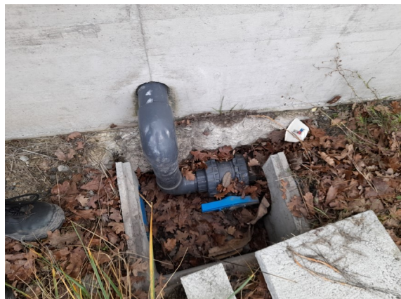
Regard extérieur avec la vanne d'isolement
