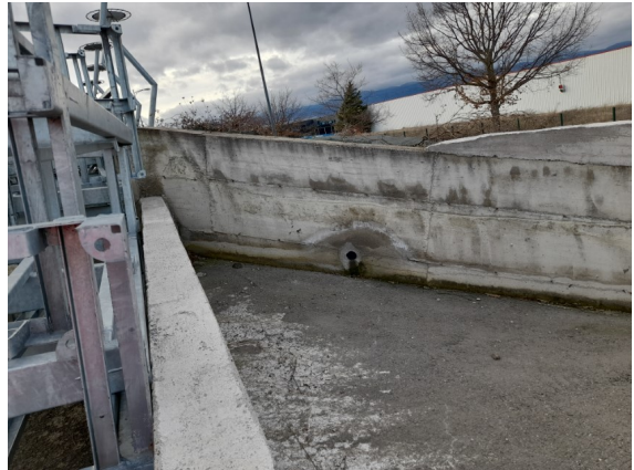
Point de rejet du séparateur d'hydrocarbures dans le bassin de confinement
