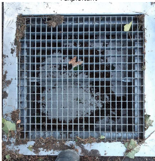
Grille à l'intérieur du bâtiment de production (côté nord, conditionnement), scellée selon l'exploitant
