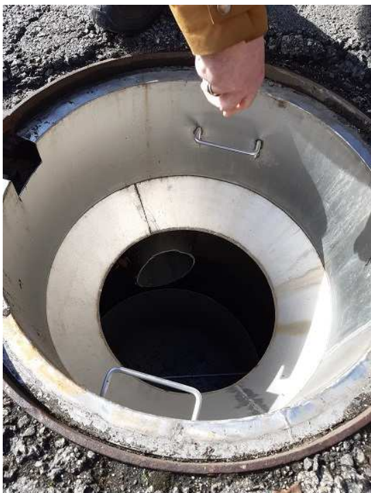
Exemple 3 de grille extérieure surmontée d'un entonnoir pour canaliser les effluents vers la grille
