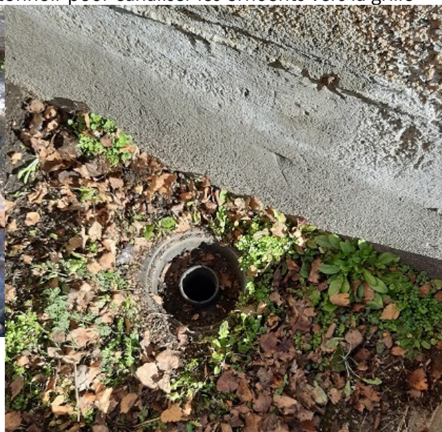
Exemple 3 de grille extérieure surmontée d'un entonnoir pour canaliser les effluents vers la grille
