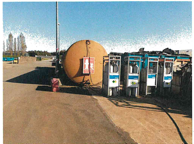
Photo 6 : Citerne incendie de 120 m 3 . Noter la présence de cadres de bouteilles d'oxygène devant le point de raccordement du tuyau des pompiers
