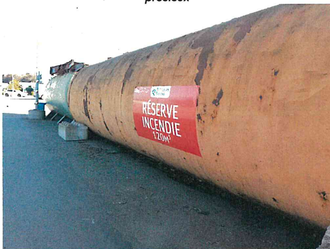
Photo 7 : Citerne incendie de 120 m 3 . Noter la vétusté de la peinture et la présence de corrosion
