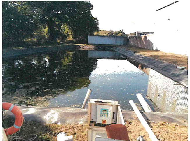
Photo 4 : bassin de confinement des eaux collectées sur le site. Au premier plan, la commande permettant de stopper le fonctionnement de la pompe de relevage, située dans l'enceinte clôturée du bassin.
