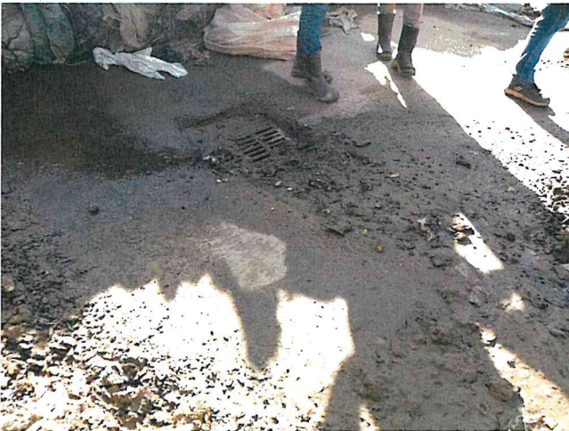
Photo 3 : grille de collecte des eaux de la plateforme étanche, située au droit de la zone au sein de laquelle est survenu l'incendie
