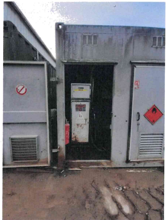
Stockage de gasoil su rétention
