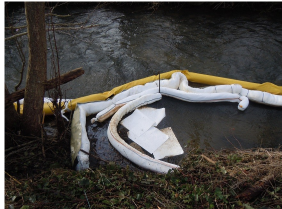
Barrage sur site (présence d'hydrocarbures)
