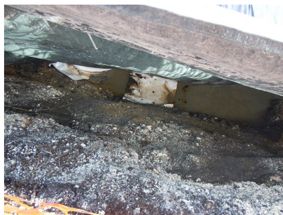
Présence d'un mélange eau-hydrocarbures Fond de fouille n°2
