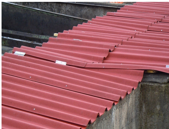
Plaques de type "onduline" et problème de pente (point bas) qui renvoie les eaux météoriques dans le point "arrière-hangar"
