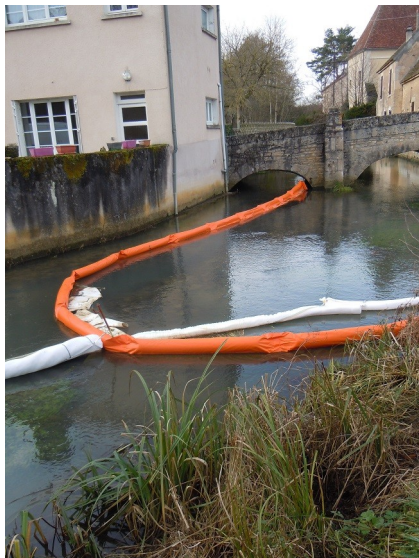
Barrage à 1 km en aval du site (présence de débris organiques et de traces d'hydrocarbures)
