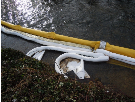
Barrage sur site (présence d'hydrocarbures)
