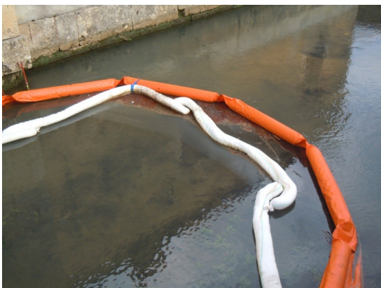
Barrage à 1 km en aval du site (présence de débris organiques et de traces d'hydrocarbures)
