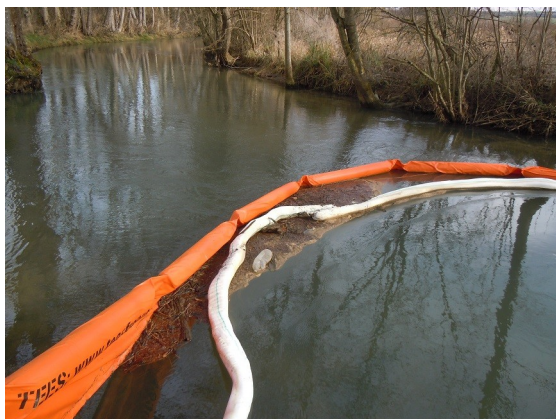
Barrage à 2,5 km en aval du site (présence de débris organiques, d'une bouteille en plastique et de traces d'hydrocarbures)
