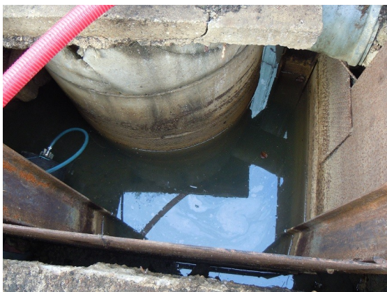
Poste de relevage (traces d'irisation)
