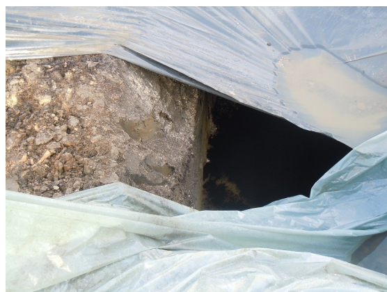
Présence d'un mélange eau-hydrocarbures Fond de fouille n°1
