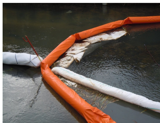
Barrage sur site (présence d'hydrocarbures)
