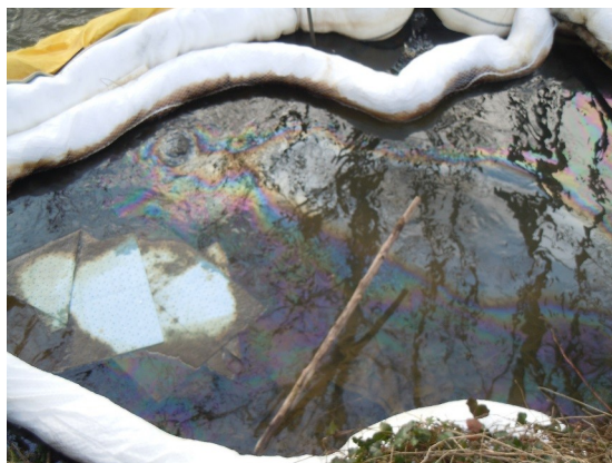
Barrage flottant sur le site
