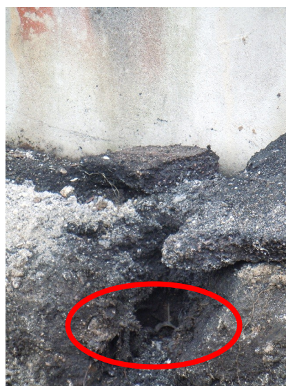
Canalisation mise à jour reliée à la rétention des deux cuves
