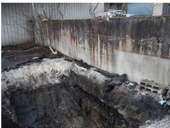
Excavation réalisée côté sud de la rétention des deux cuves à fioul et pompage au niveau d'un piézomètre
