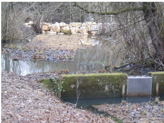
Barrage en enrochements libres et massif filtrant mis en place au centre du muret de cloisonnement existant (sous-bief 2)
