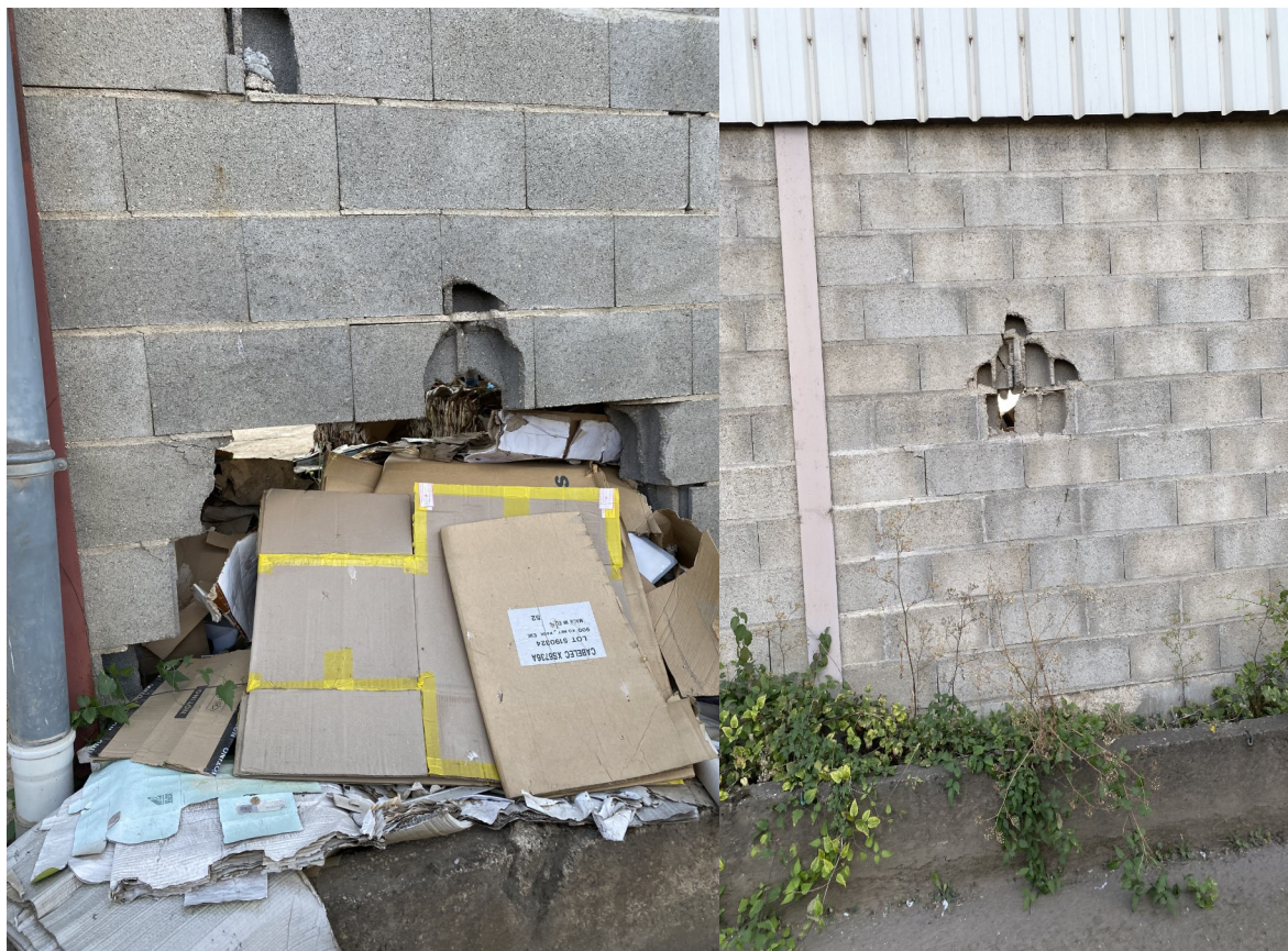
Figure 1 : mur endommagé séparant les alvéoles de déchets
