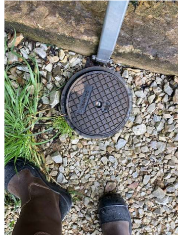
Site de Belforêt en Perche – Couverture de protection d'une prise de terre déboîté
