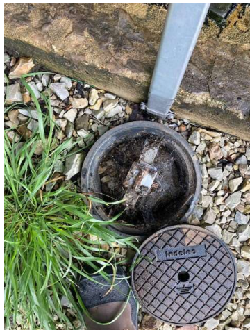
Site de Belforêt en Perche – Couverture de protection d'une prise de terre déboîté
